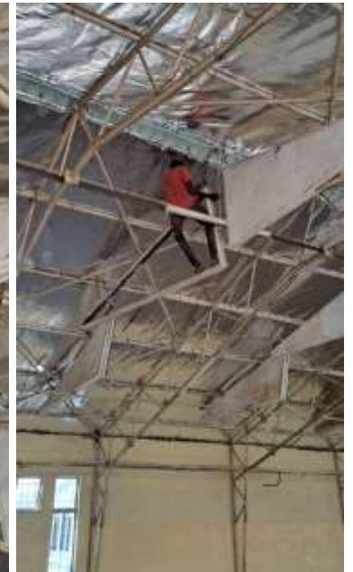
Unterhalb des Wellblechdaches wurde eine Aluminiumfolie befestigt als Wärmeisolation. Zudem hellt die Folie das Gebäude auf, indem es das Licht reflektiert. Die Isolationswirkung der Folie ist bemerkenswert.
