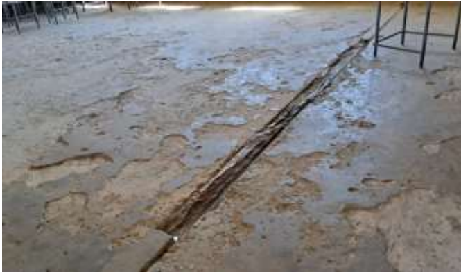
Bilder links: die Böden sind übersät mit Löchern und Rissen. Bild rechts: der Sand wird abgeladen.
