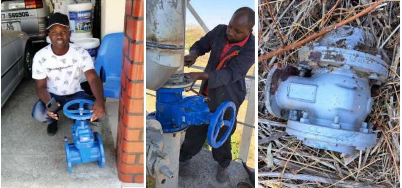
Links Supervisor Joseph Chipindi mit einem der drei Schieber, geliefert mit grosser Verspätung. Mitte und unten, Brian Chilala's Bruder bei der Montage einer der drei Schieber. Oben rechts: ein alter Schieber.
