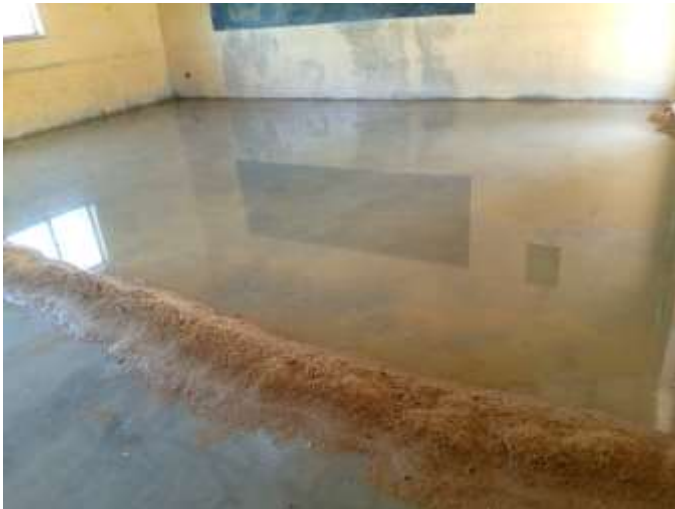
Oben: Nachdem die Zementböden abgezogen wurden, werden sie während ein paar Tagen gewässert zur Härtung des Zements. Unten: die Böden wieder im alten Glanz und die Schulmöbel stehen wieder stabil
