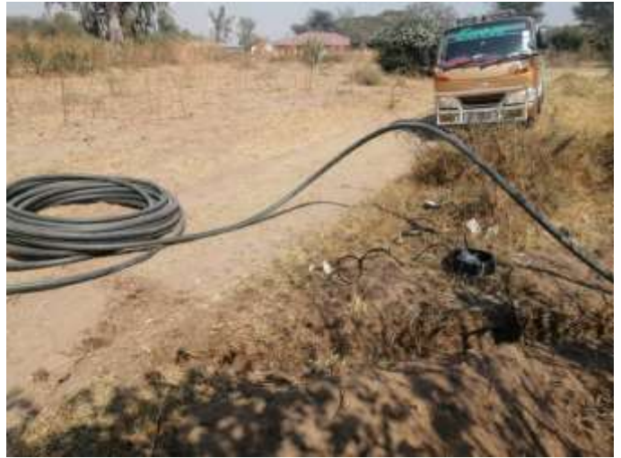
Oben: Der Schlauch, womit das Wasser vom Brunnen zum Wassertank geführt wird. Unten links: Pumpe und andere Materialien für den Brunnen. Rechts: das Überprüfen der Komponenten.
