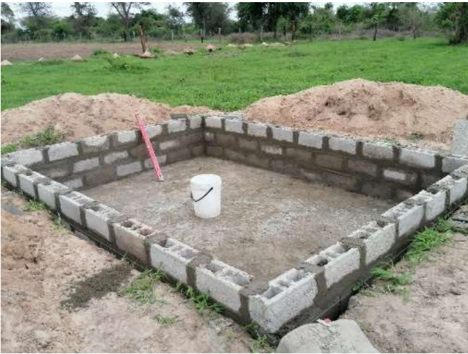
Die Erstellung der zwei Wasserreservoirs für die Bewässerung.
