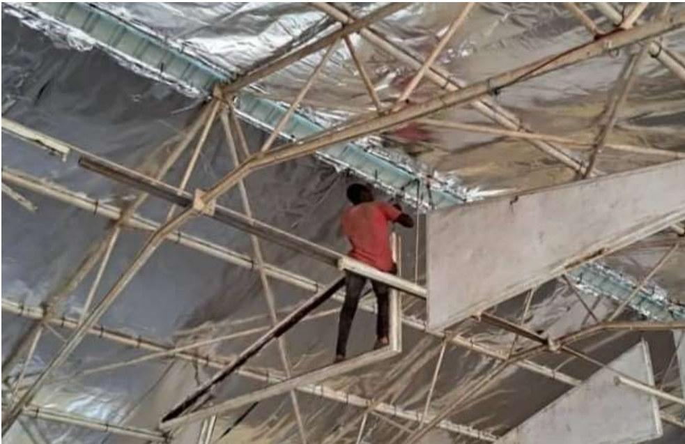
Unterhalb des Wellblechdaches wurde eine Aluminiumfolie befestigt als Wärmeisolation. Zudem hellt die Folie das Gebäude auf, indem es das Licht reflektiert. Die Isolationswirkung der Folie ist bemerkenswert.
