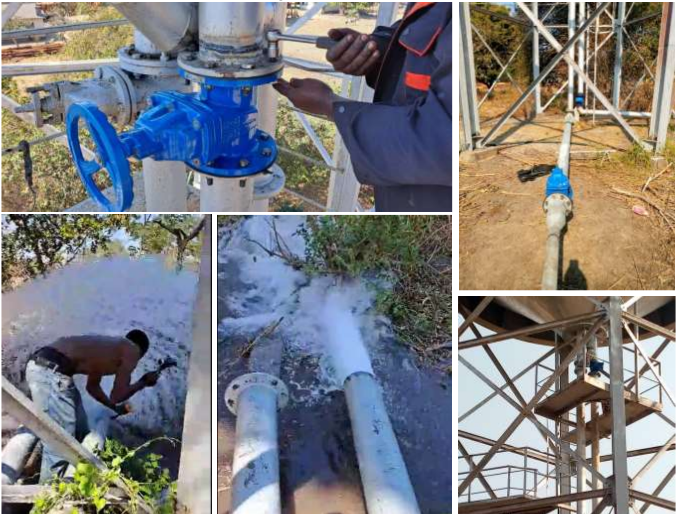
Links Supervisor Joseph Chipindi mit einem der drei Schieber, geliefert mit grosser Verspätung. Mitte und unten, Brian Chilala's Bruder bei der Montage einer der drei Schieber. Oben rechts: ein alter Schieber.
