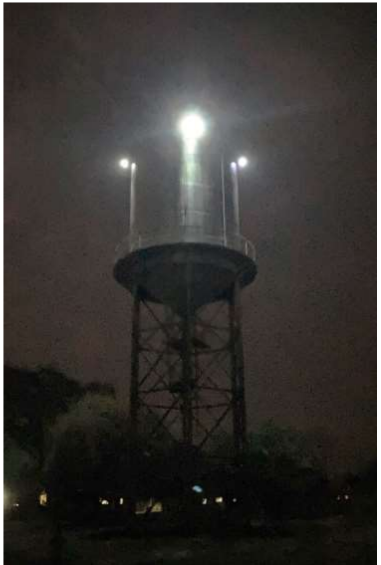
Bevor die Wasserleitung am Tank angeschlossen wird, läuft das Wasser so lange ins Freie, bis es klar ist. Aus Sicherheitsgründen wurde vier Solarlampen auf dem Turm montiert.
