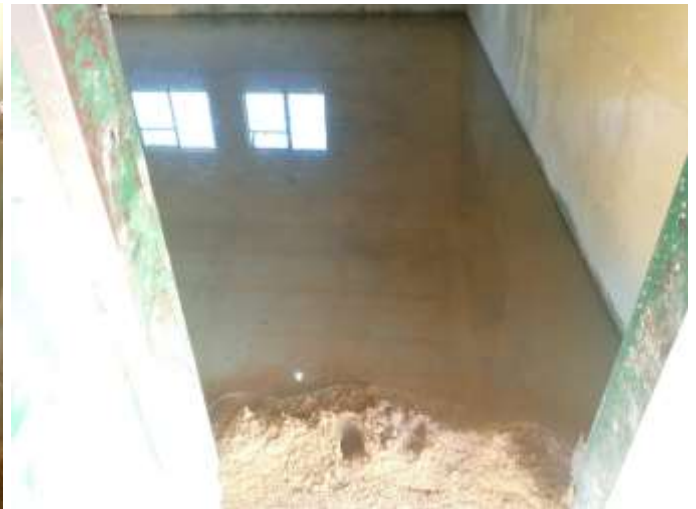
Oben: Nachdem die Zementböden abgezogen wurden, werden sie während ein paar Tagen gewässert zur Härtung des Zements. Unten: die Böden wieder im alten Glanz und die Schulmöbel stehen wieder stabil
