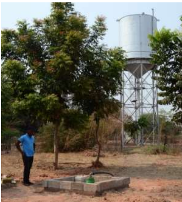
Bevor die Wasserleitung am Tank angeschlossen wird, läuft das Wasser so lange ins Freie, bis es klar ist. Aus Sicherheitsgründen wurde vier Solarlampen auf dem Turm montiert.
