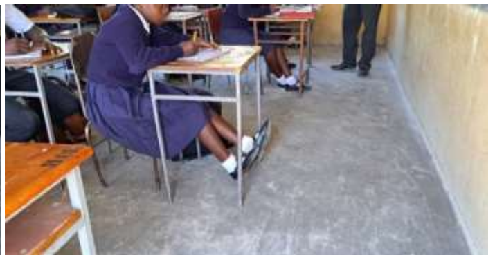
Oben: Nachdem die Zementböden abgezogen wurden, werden sie während ein paar Tagen gewässert zur Härtung des Zements. Unten: die Böden wieder im alten Glanz und die Schulmöbel stehen wieder stabil
