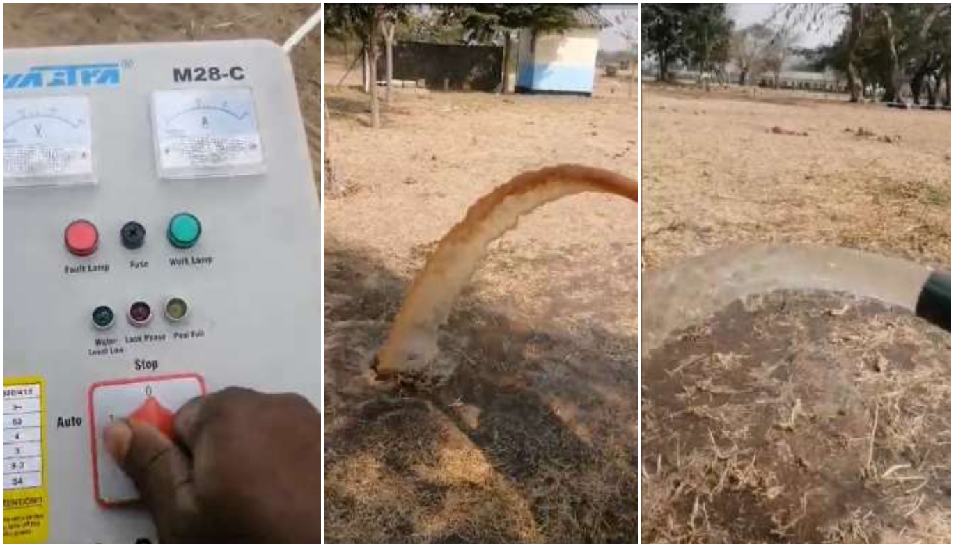
Bevor die Wasserleitung am Tank angeschlossen wird, läuft das Wasser so lange ins Freie, bis es klar ist. Aus Sicherheitsgründen wurde vier Solarlampen auf dem Turm montiert.
